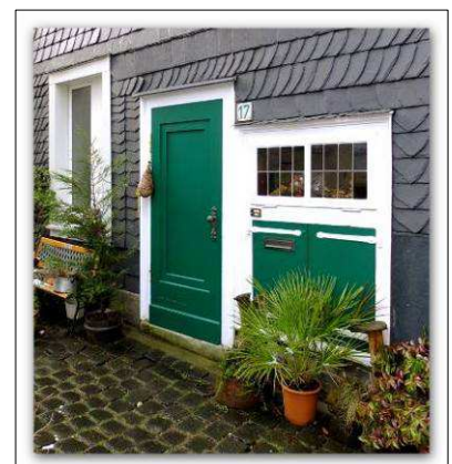
Kölner Straße 17 Eingangstür mit Bierluke 7
