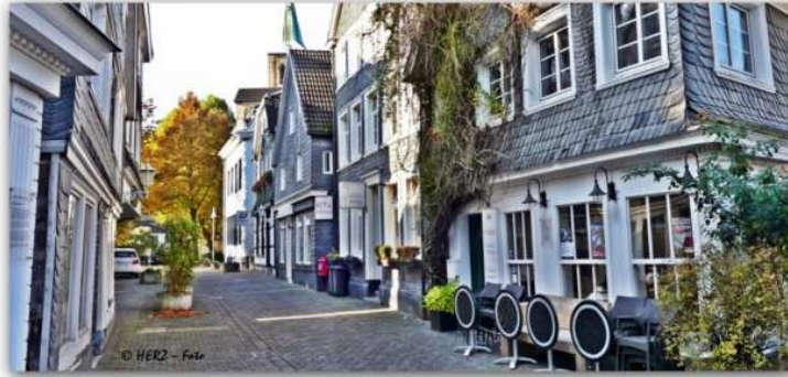
Schwelm, Kirchstraße 14 - 22 © HERZ - Panoramafoto
